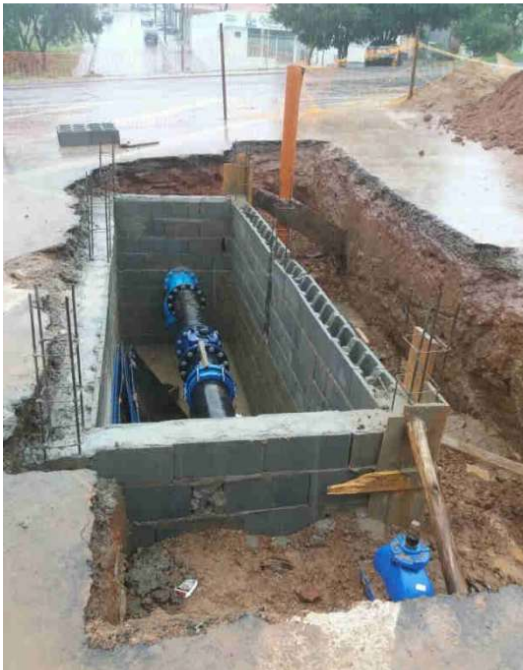
Figura 1 - Exemplo de Caixa de VRP (em construção) Foto: Acervo SEMAE.
