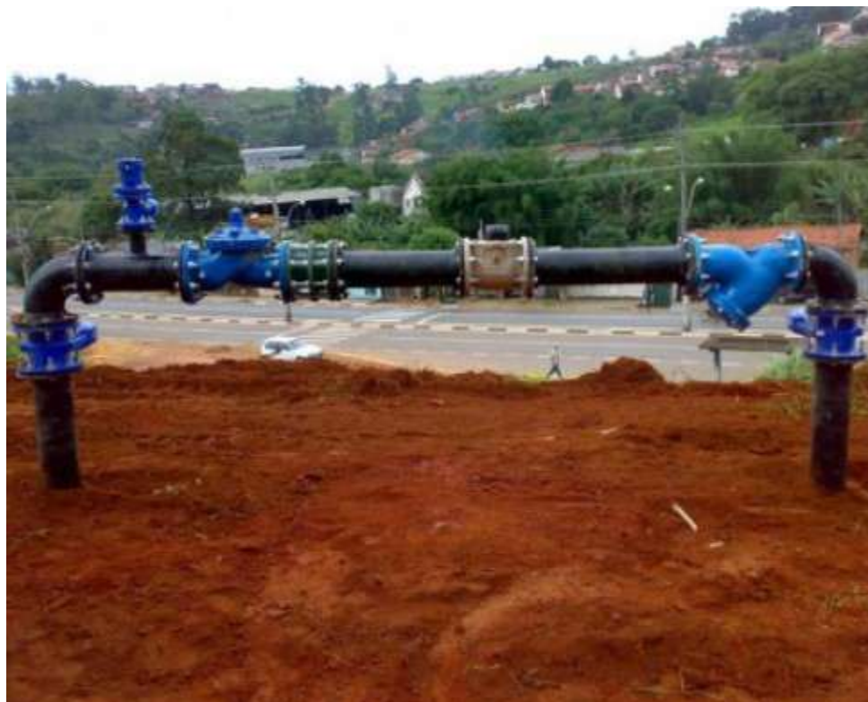
Figura 3 – Exemplo de Cavalete de VRP – Foto: COBRAPE para Sabesp
