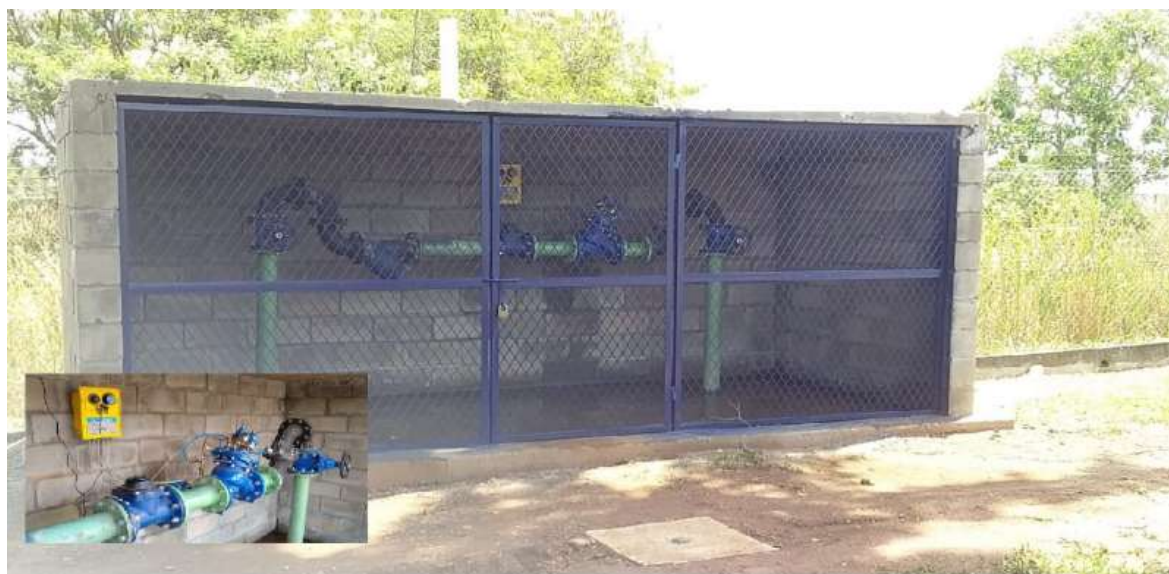
Figura 4 - Exemplo de Cavalete de VRP - Foto: acervo SEMAE.
